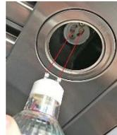
Aligner les pattes des nouvelles ampoules avec les deux trous de la fente du socle de la douille.
