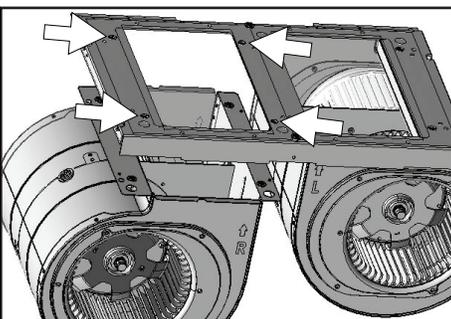
4. Fixez le ventilateur simple à la plaque du ventilateur double à l'aide des (4) vis précédemment retirées à l'étape 3.
